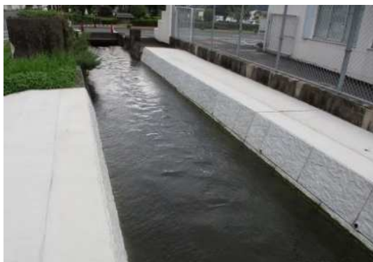
更新した農業用基幹水利施設
