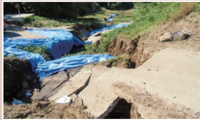
平成29年5月16日 朝地町綿田地区地すべり発生
