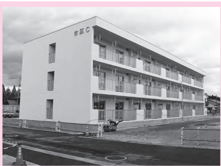
▲建設中の市原住宅3期工事
