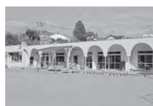
旧三重幼稚園舎
