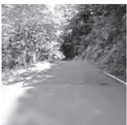
▲木浦内2号線(一部)
