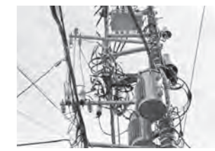
ケーブル工事(イメージ)
