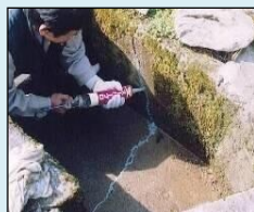
ひび割れの補修
