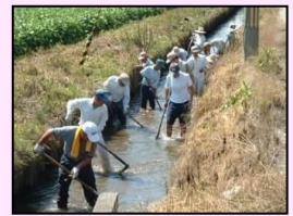
水路の泥上げ
