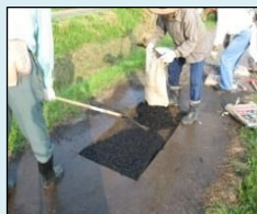
農道の部分補修
