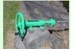
ゲート、バルブの更新
