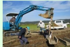
コンクリート水路の更新
