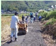
未舗装農道の舗装
