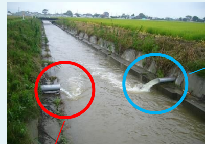
田んぼダム実施
