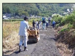
未舗装農道の舗装
