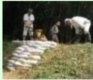
漏水箇所の補修
