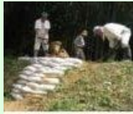
漏水箇所の補修
