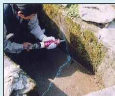
ひび割れの補修
