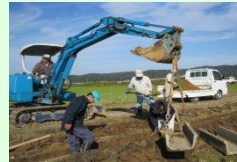
コンクリート水路の更新
