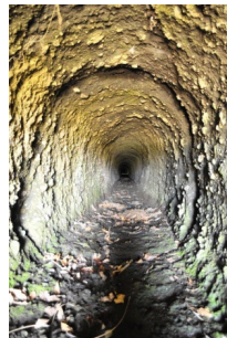
富士緒井路神明線隧道
