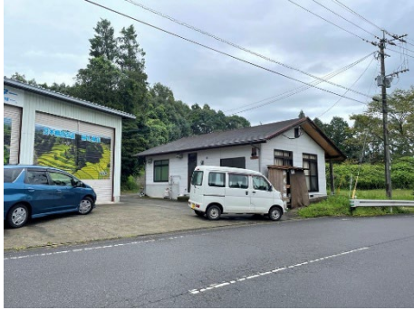
ライスセンターに隣接する集会所
