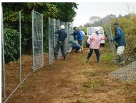
防護柵の設置
